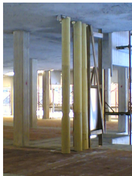
Coppelle lana di roccia ROCKCONFORT per Insonorizzazione impianti scarico
